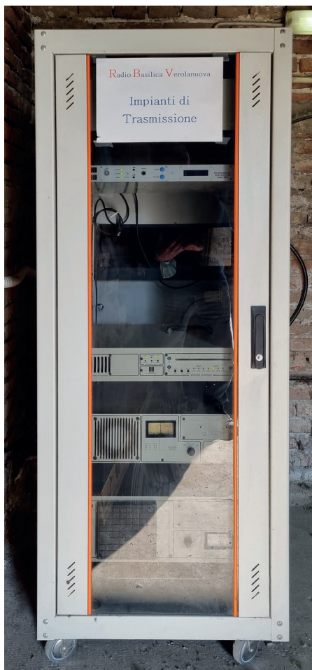
Gli impianti di trasmissione di RBV con l'evidente spazio vuoto lasciato dal trasmettitore guasto
