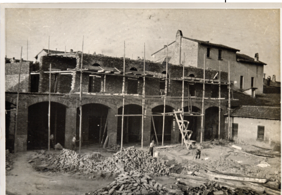
1942 - La costruzione avanza
